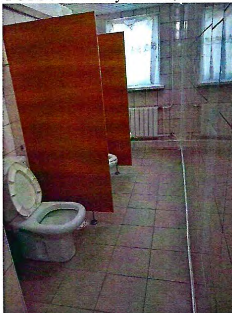
ФОТО № 54 Санузел общий
