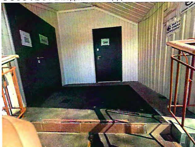
ФОТО № 14 Входная площадка
