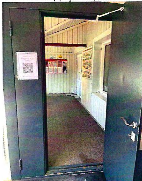
ФОТО № 16 Дверь входная
