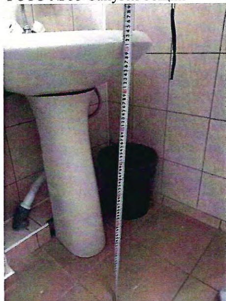
ФОТО № 53 Санузел общий
