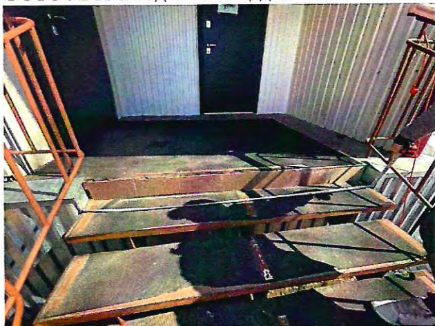
ФОТО № 13 Входная площадка
