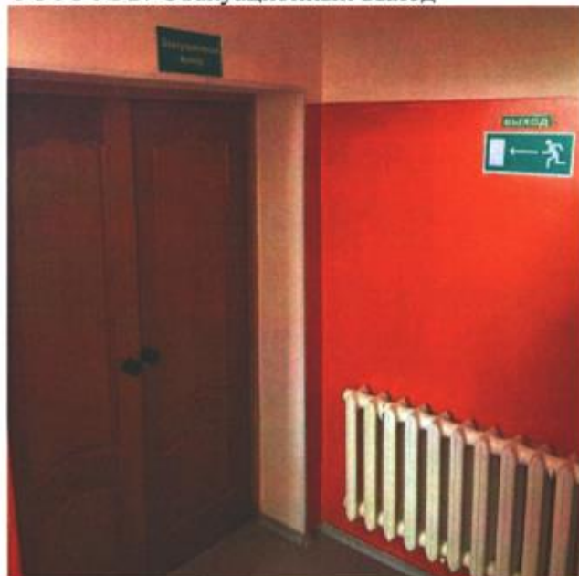
ФОТО № 27 Эвакуационный выход
