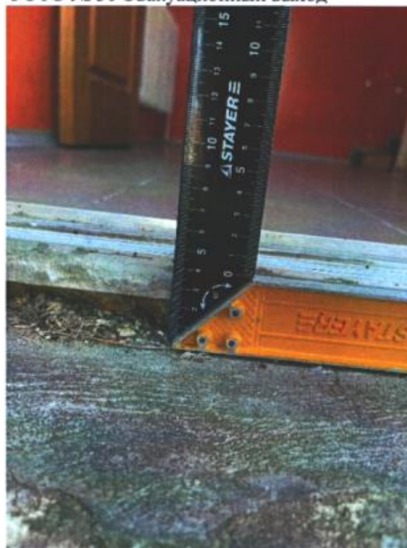
ФОТО № 30 Эвакуационный выход
