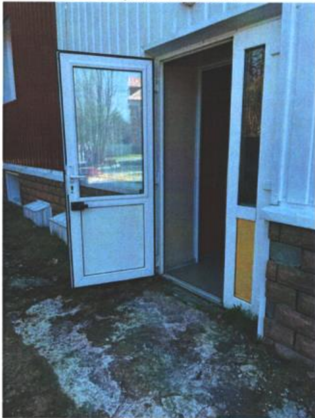
ФОТО № 31 Эвакуационный выход
