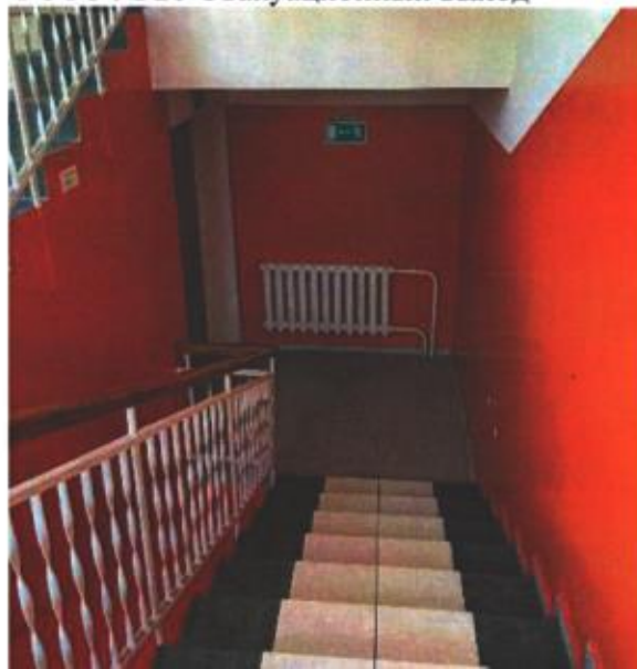
ФОТО № 26 Эвакуационный выход
